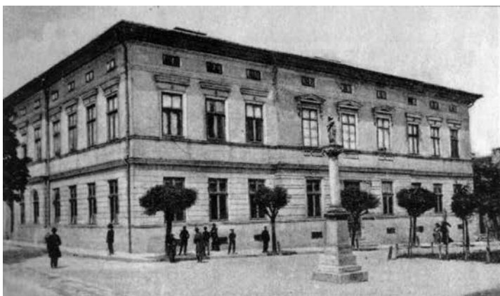
Budynek szkoły, do której uczęszczała Krystyna Szofer
